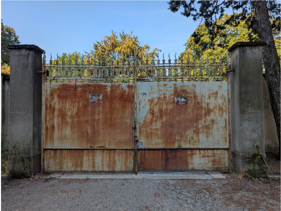
Cancello metallico oggetto di intervento manutentivo – Vista da cortile interno
