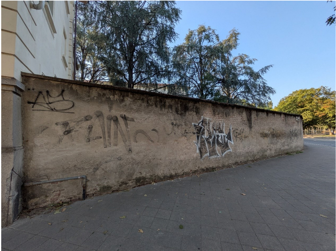
Recinzione esterna – Corso G. Garibaldi, angolo Corso A. Garibaldi
