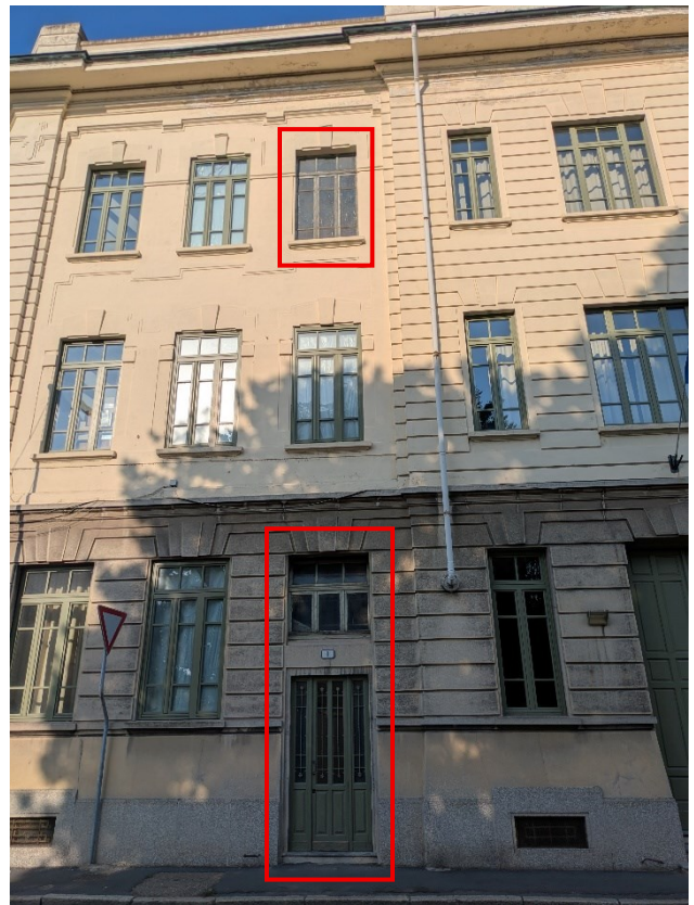
Serramenti da sostituire e restaurare – Via Cadorna
