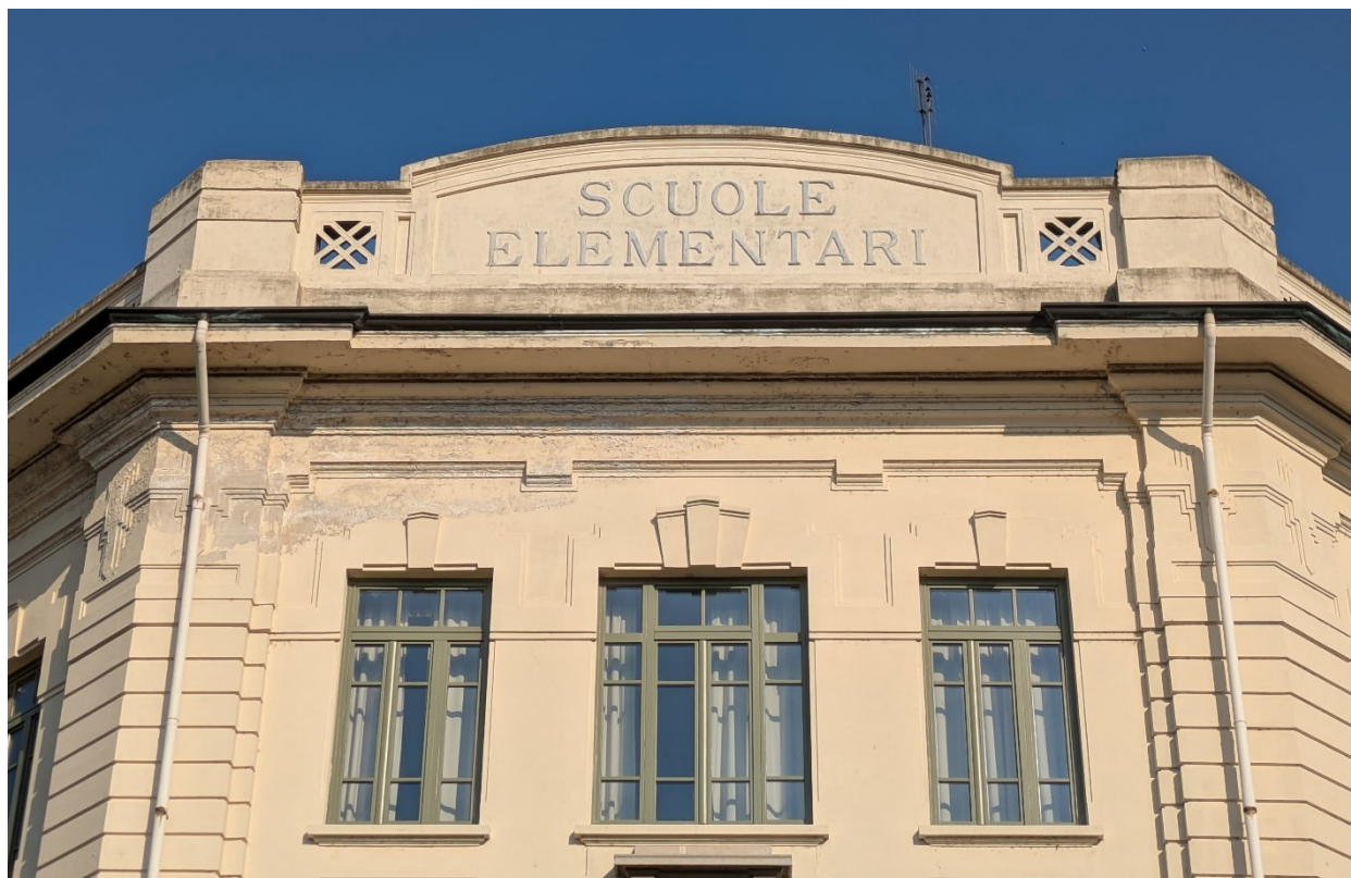
Intonaco e tinteggiatura oggetto di rifacimento – Via Diaz, angolo Via Cadorna
