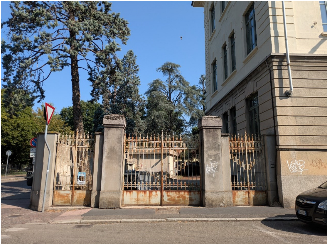
Cancelli metallici oggetto di intervento manutentivo – Via Diaz
