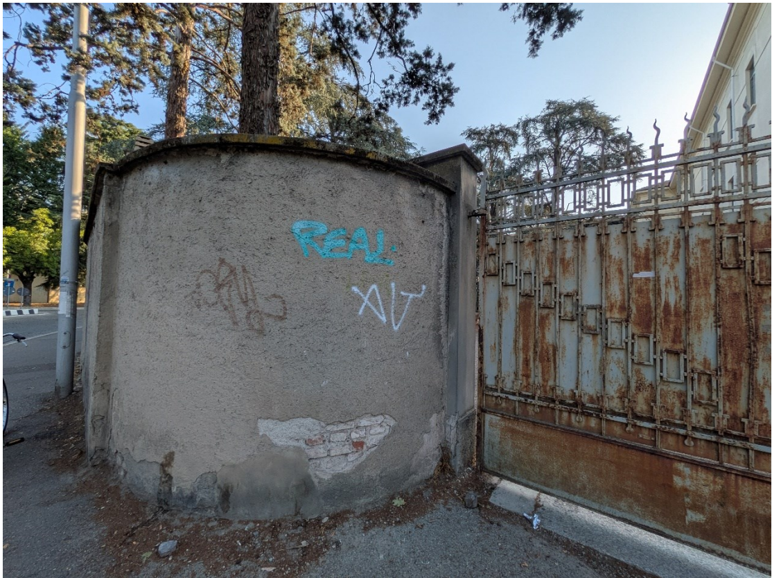
Recinzione esterna – Corso A. Garibaldi
