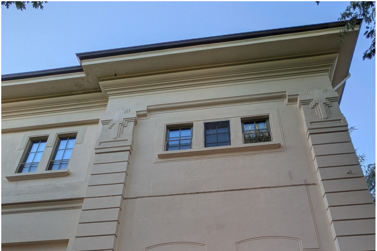
Parapetti metallici oggetto di revisione – Corso G. Garibaldi
