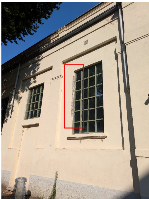
Spalletta da risanare – Vista da cortile interno
