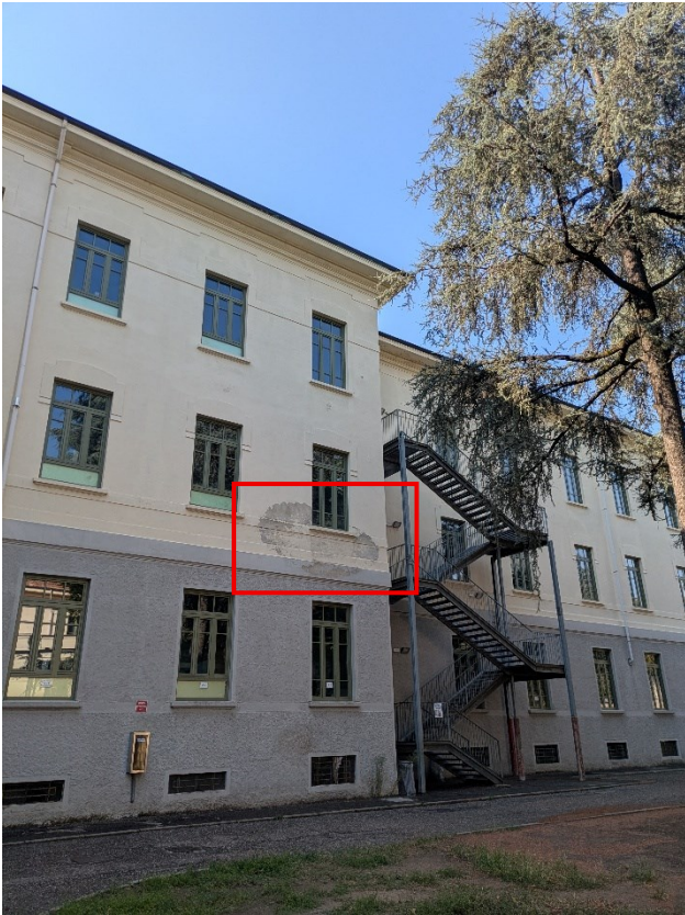
Intonaco e tinteggiatura oggetto di rifacimento – Vista da cortile interno
