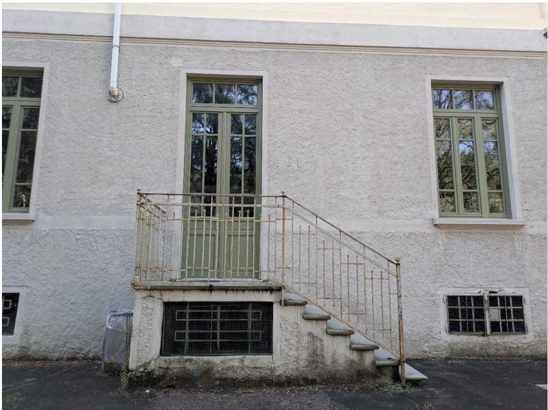
Scala di accesso oggetto di intervento manutentivo – Vista da cortile interno
