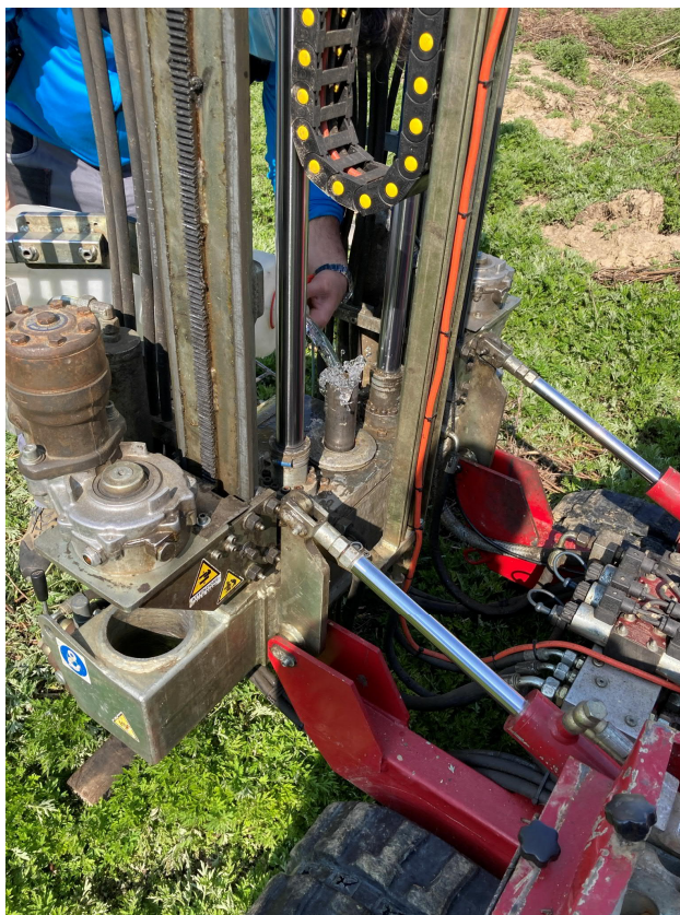
Prova di permeabilità del momento di riempimento fino a rifiuto idrico
