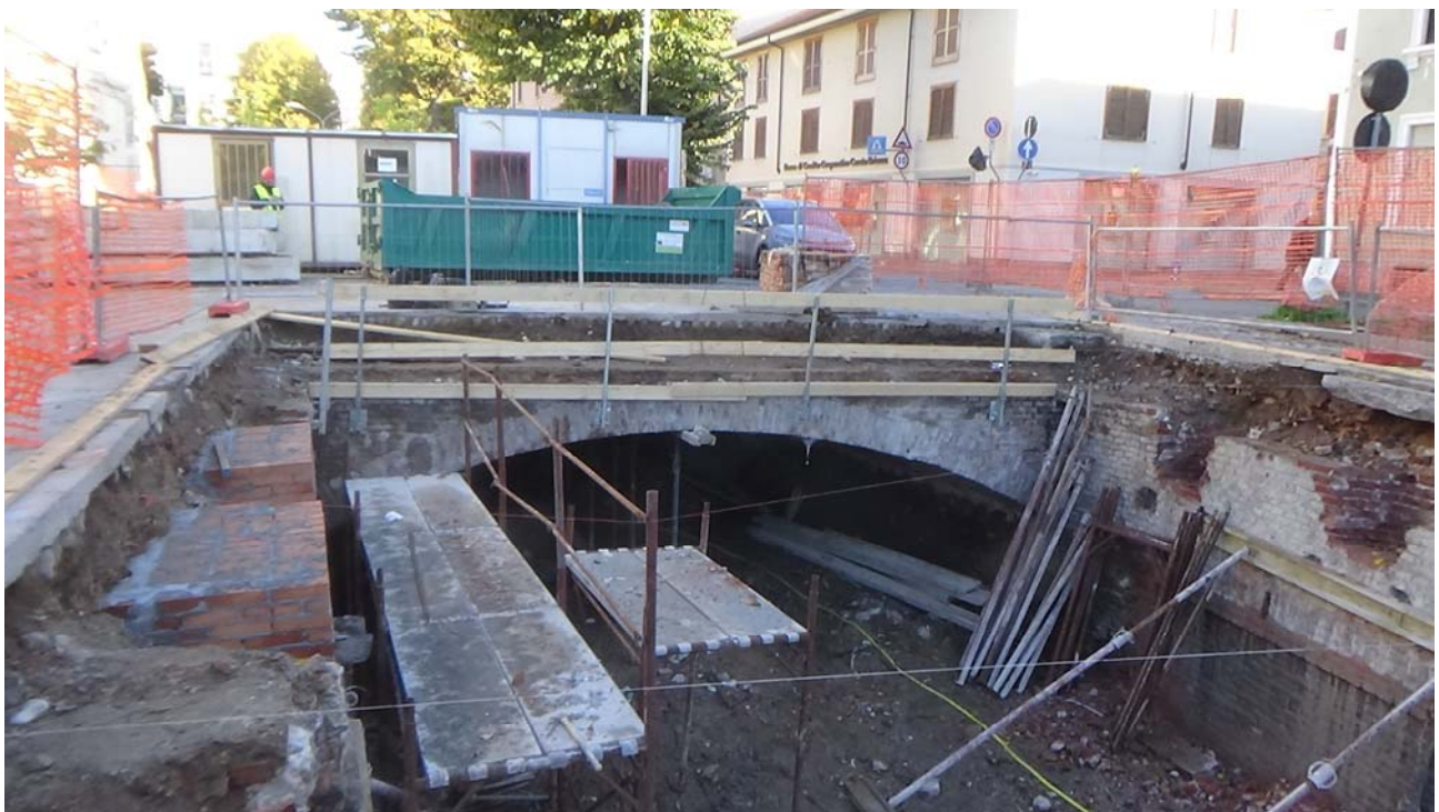
Fig. 2.3 – Il ponte oggetto di studio
