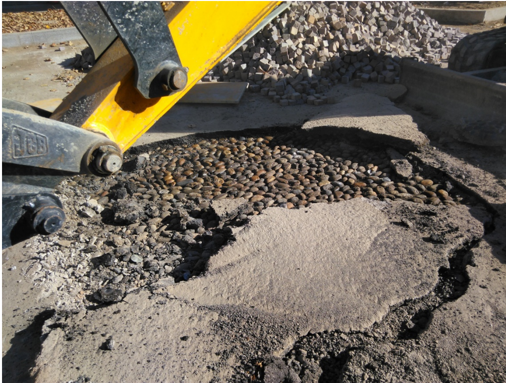
Fig. 2.1.2 – La stratigrafia presente sull’estradosso del ponte in muratura
