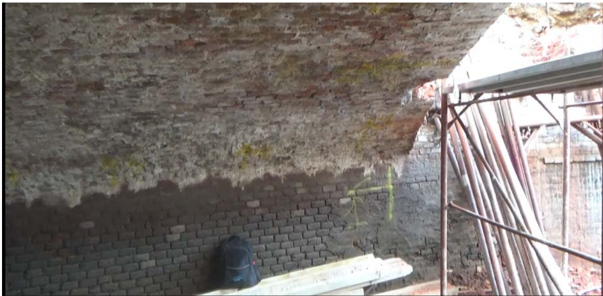
Fig. 2.1.3 – I muri del canale erano rivestiti con intonaco, tracce di quest’ultimo sono ancora visibili oggi, dove l’intonaco è scomparso i giunti di malta risultano leggermente scavati: 2-4cm
